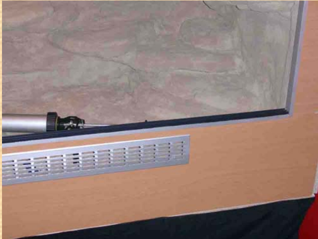
Mit U-Aluprofilen werden die Schnittkanten verkleidet, und die Scheibenprofile darauf geklebt.
