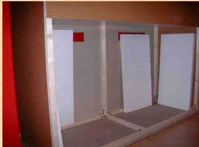
50mm Styroporplatten werden an die Rück- und Seitenwände geklebt.
