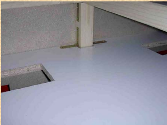
Verstärkungen mit weiteren kleinen Winkeln, hinten ...
