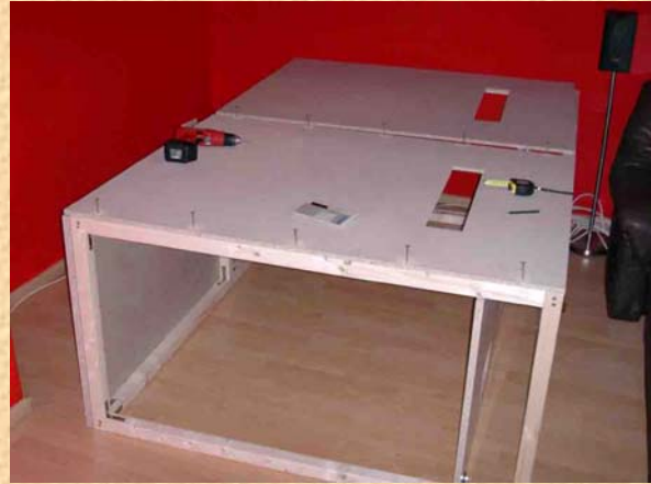
Die Rückwände werden an das Gerüst geschraubt.
