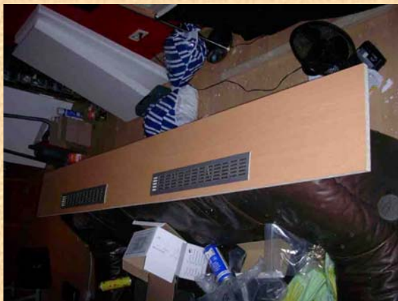
In die Fronblende werden die Leichtmetalllüfter eingesetzt.
