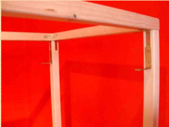
Winkel zur Befestigung der Zwischendecke werden an das Grundgerüst geschraubt.
