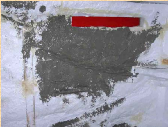
Die Rückwand wird mit Fliesenkleber bestrichen.
