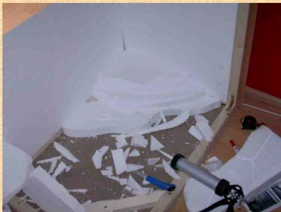
Aus zerschnittenen Styroporplatten werden Erhöhungen ...
