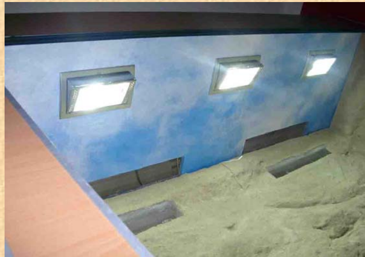
Nach dem einkleben der Fototapete werden die HQI Strahler installiert.
