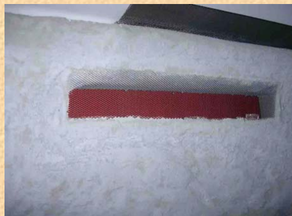
... und in die Fliesenkleberschicht integriert.
