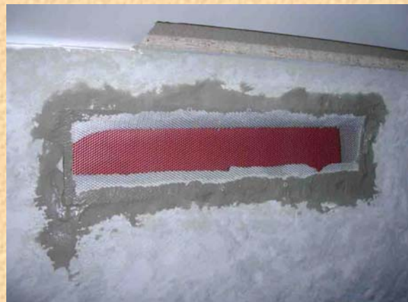
Die Lüftungsschlitze werden in die Rückwand geschraubt ....
