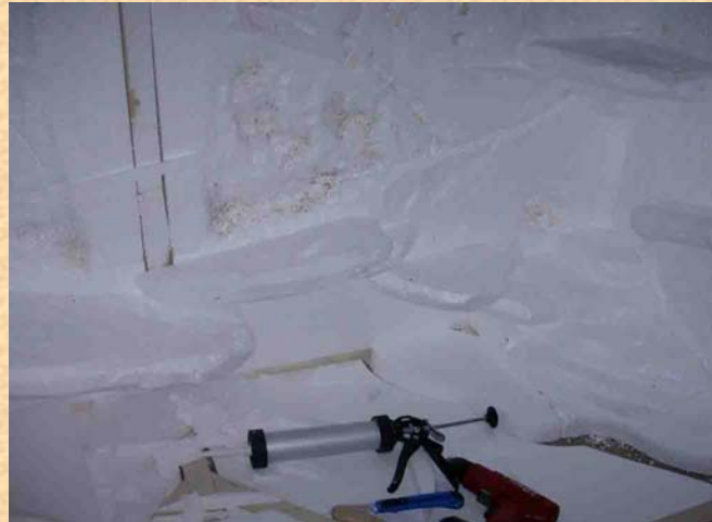
Die Wände werden mit einem Teppichmesser strukturiert.
