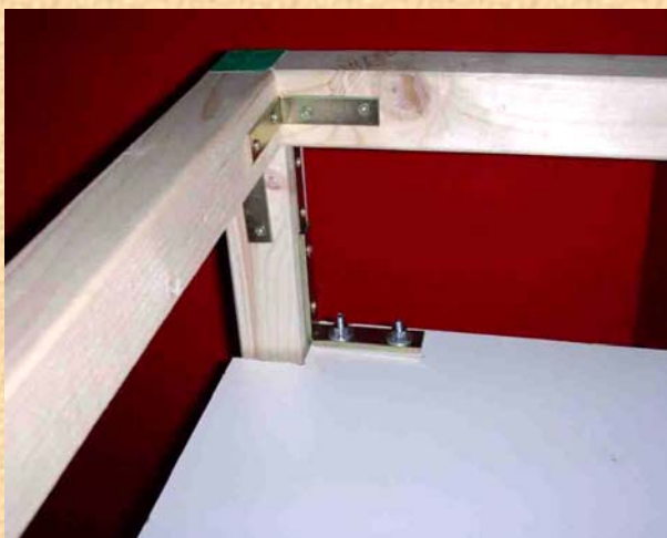
Die Zwischendecke wird mit den Schlossschrauben befestigt.
