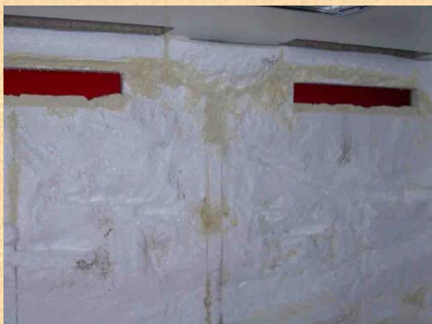
Mit PU Schaum werden die Zwischenräume in der Wand ...
